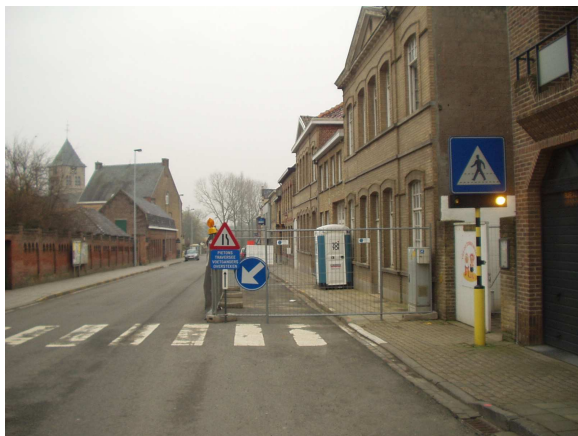
Verkeerssituatie school Baljuwstraat 1/3/2011
